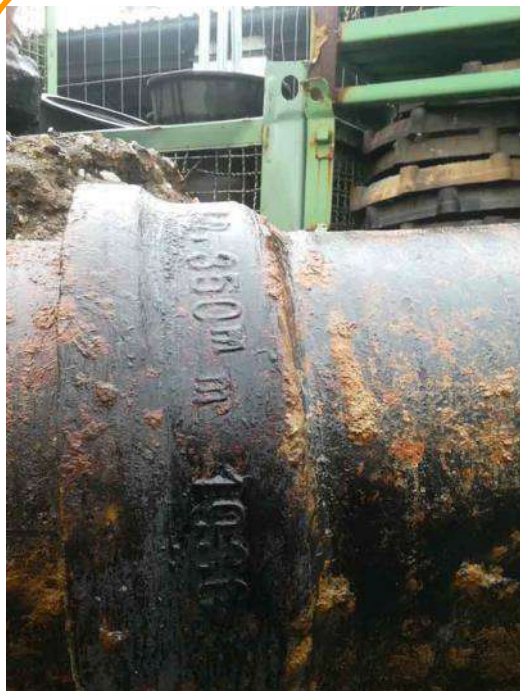
Fig. 103. Dettaglio del giunto di una tubazione in ghisa: vi è inciso il diametro: "350 mm" e l'anno di fabbricazione: "1936" (foto M. A. Breda).
