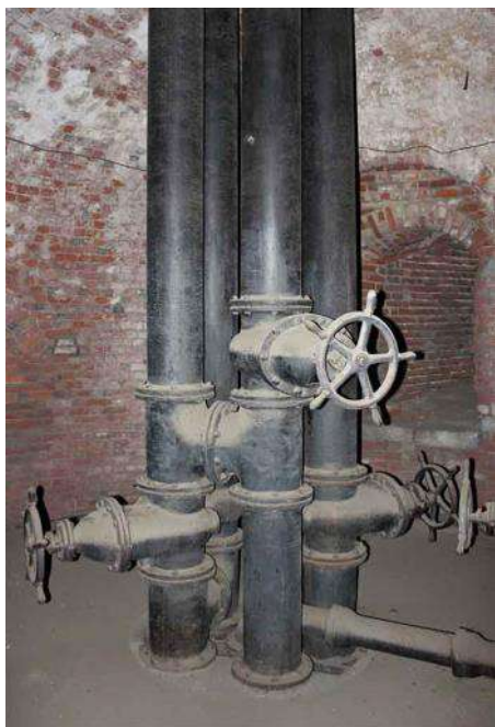
Fig. 36. Le tubature dell'impianto idraulico attraversano i vari piani del Torrione Sud sfruttando gli oculi a pavimento che originariamente mettevano in comunicazione diretta i vari livelli di casematte.
