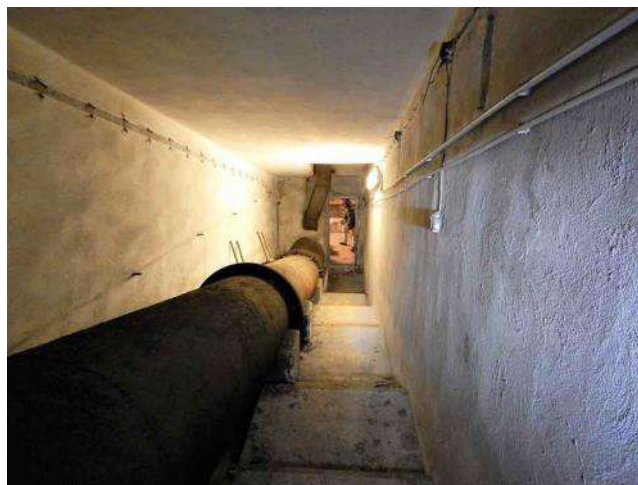
Fig. 95. Tubatura proveniente dal pozzo radiale, in disuso.
