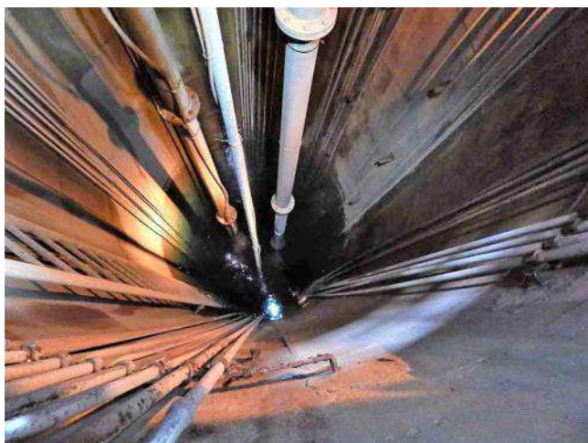
Fig. 94. Pozzo radiale della Centrale di pompaggio Testi.
