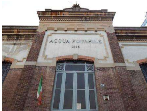
Fig. 66. Facciata della Centrale di pompaggio Anfossi.
